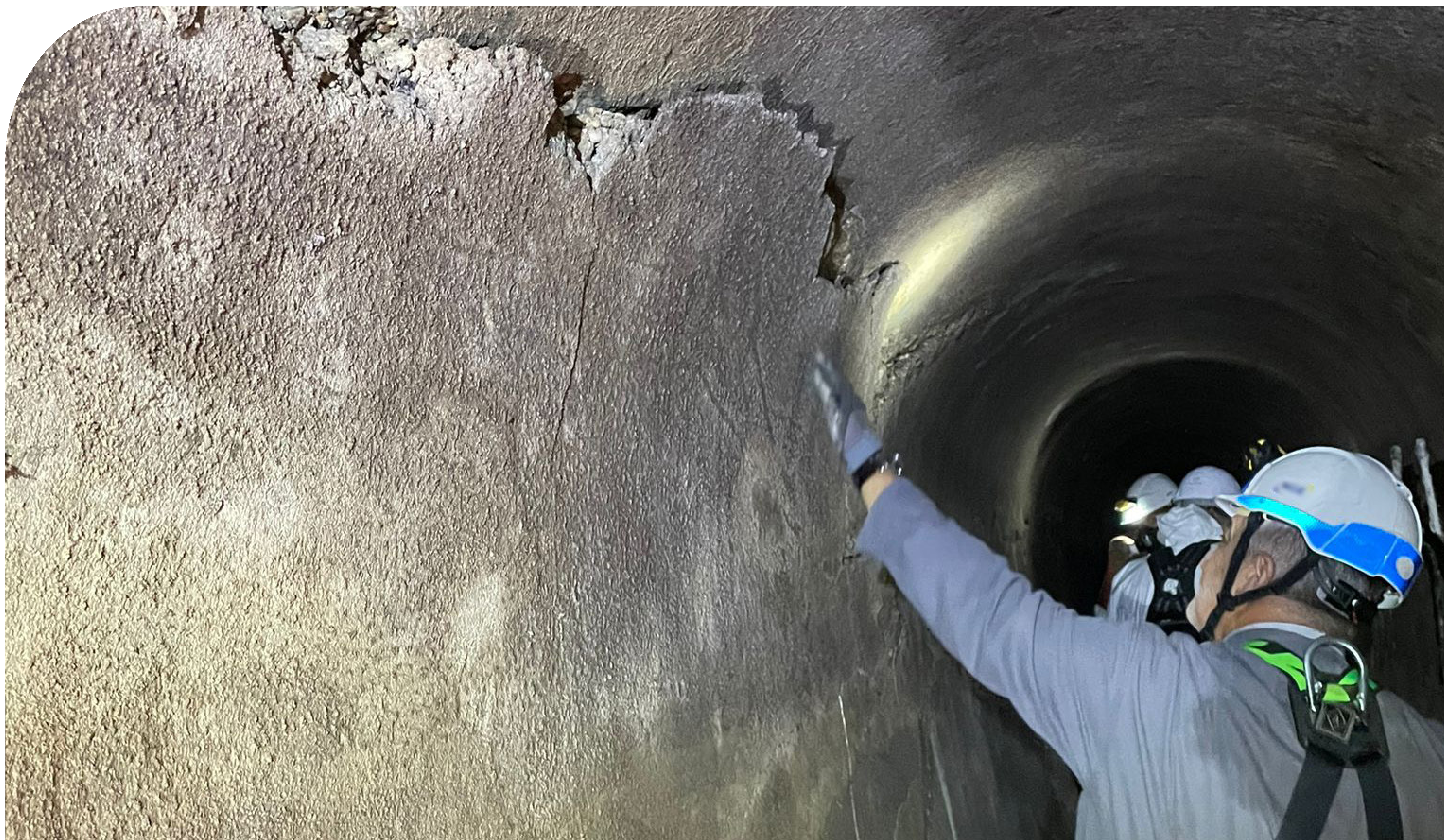
Auscultation des égouts © Département de la Seine-Saint-Denis
