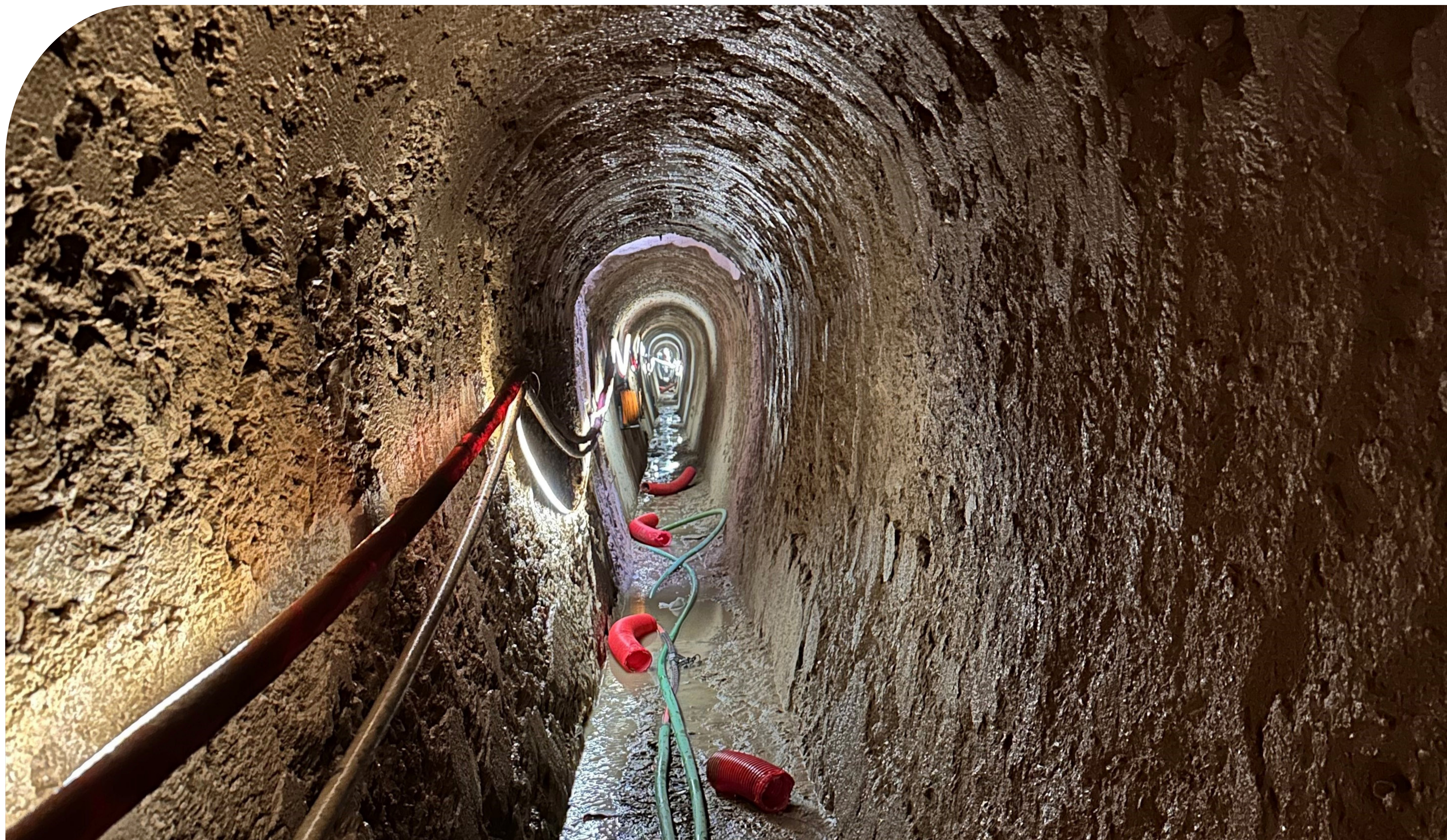
Égout après retrait du revêtement intérieur © Médiathèque NGE
