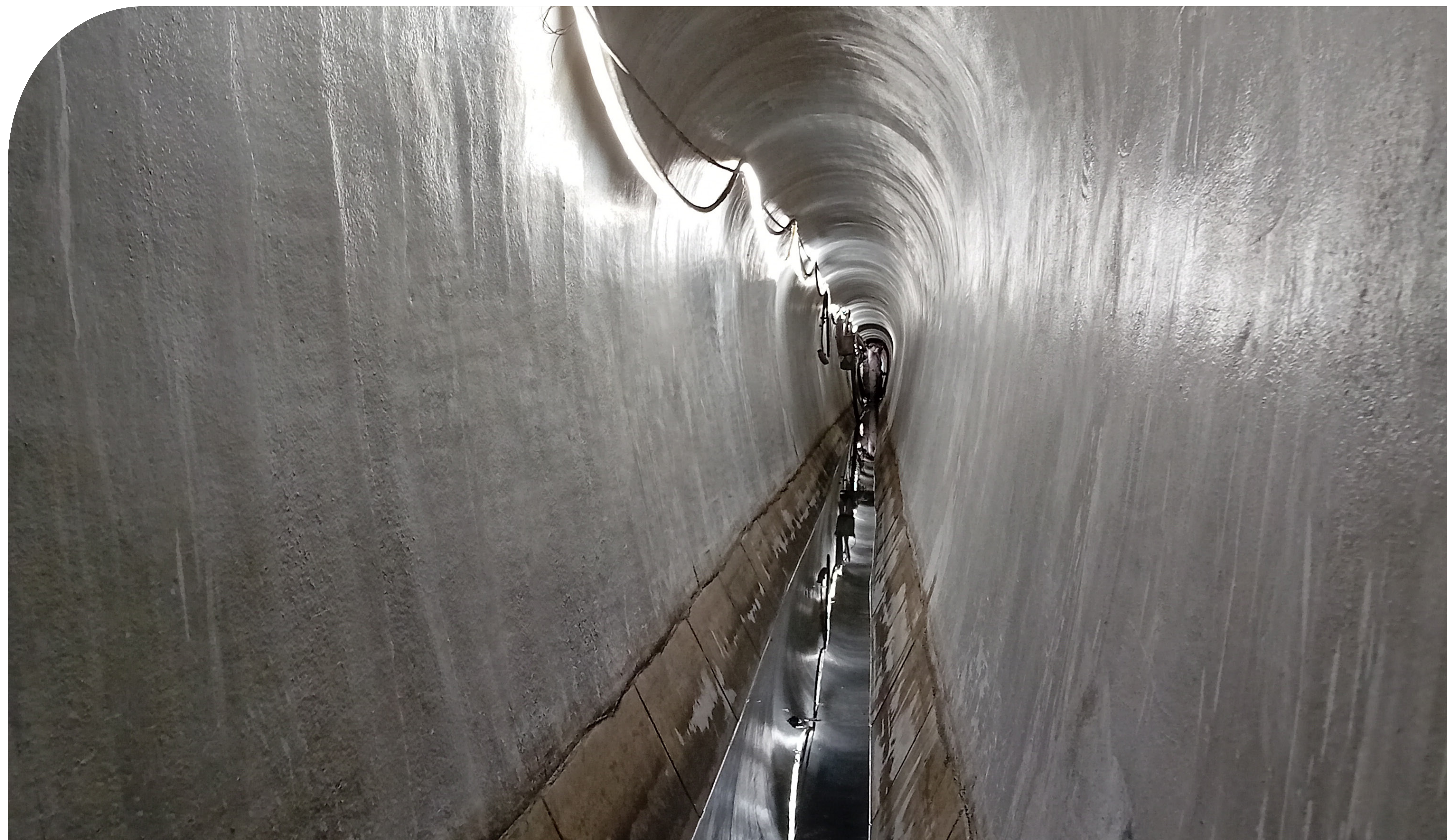
Béton lissé © Département de la Seine-Saint-Denis
