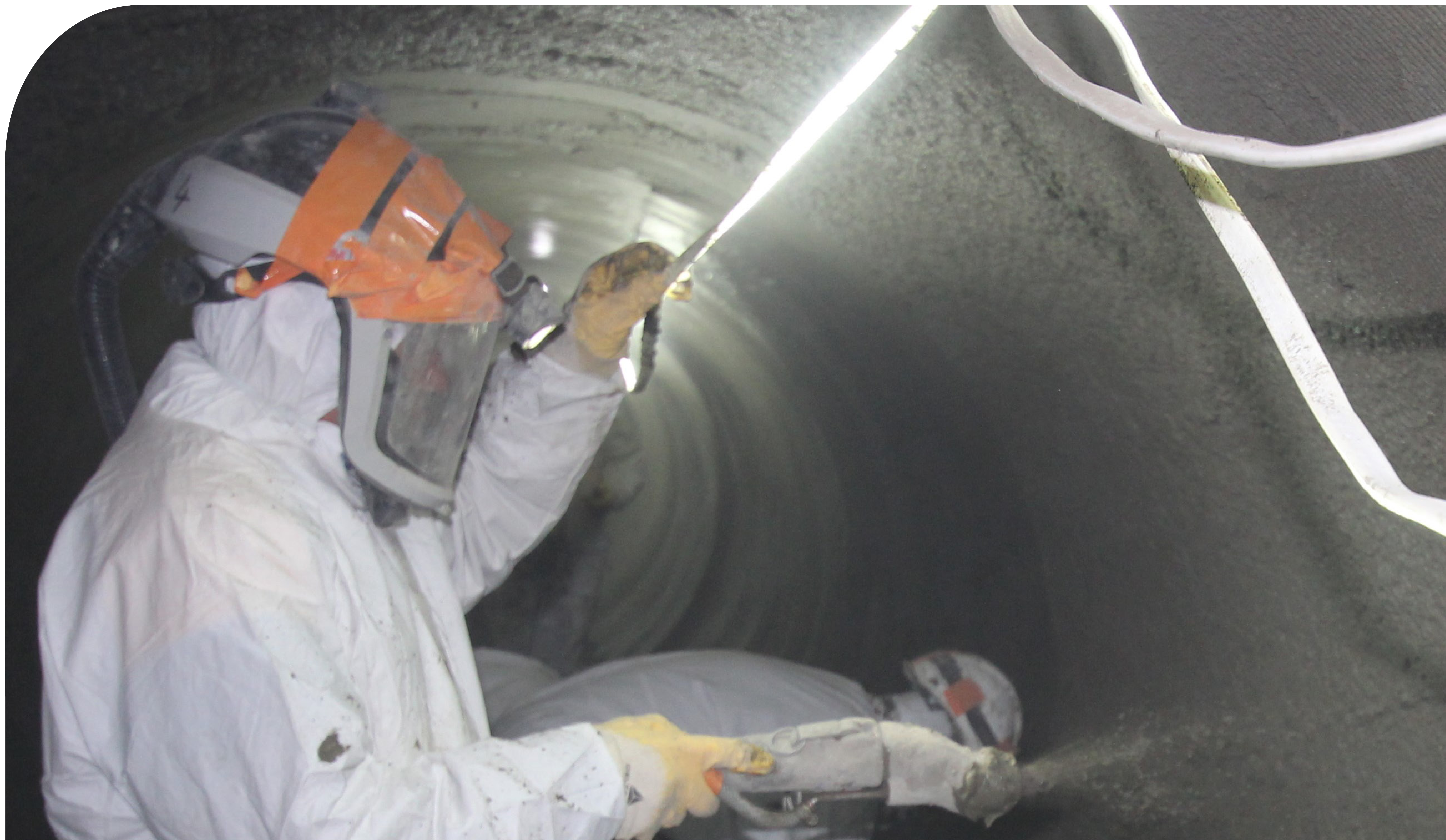
Projection du béton © Médiathèque NGE
